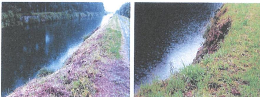
*Figure 2: Berges érodées, rive gauche du canal de Lens à Harnes*
